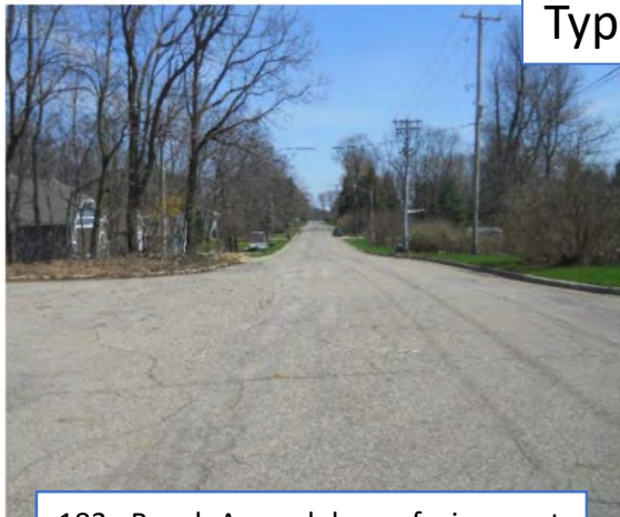
183. Beech Ave cul de sac facing west
